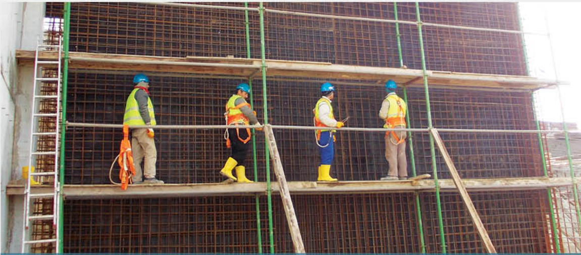
Eaton Çerkezköy OSB - Muhtelif Fabrika İnşaat ve Tadilatı
