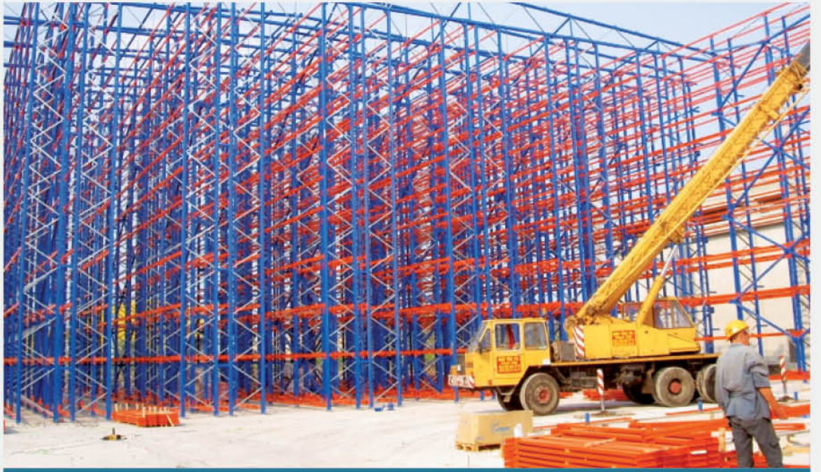
Setaş Kimya Çelik Depo Binası
