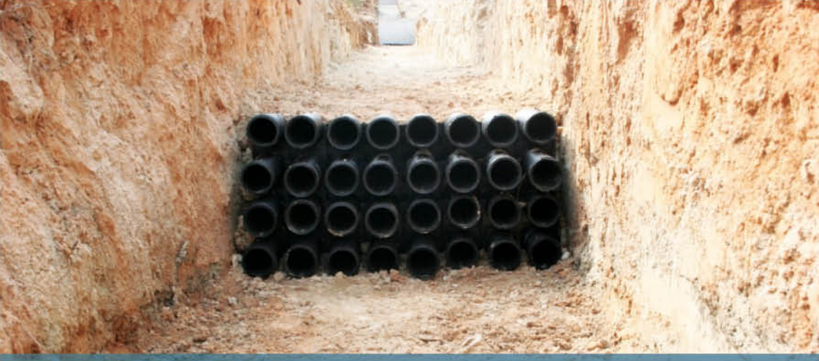
ÇOSB Yüksek gerilim altyapı inşaatı
